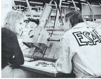
Vaisalan Oy:n EB-hitsauksella, joka oli vuonna 1973 hankittu ensimmäinen EB-laitteisto Suomessa, saavutettiin ohuiden folioiden hitsauksella tyhjä mitta-anturin sisälle. © ESAB.
